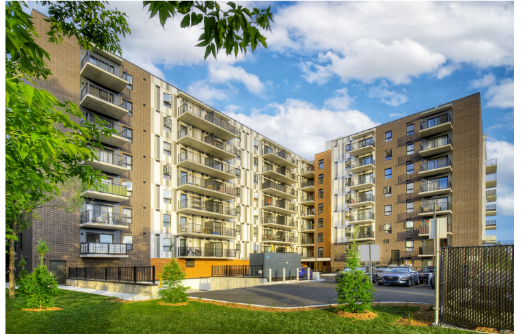
Habiter chez soi : 134 logements sur 8 étages
