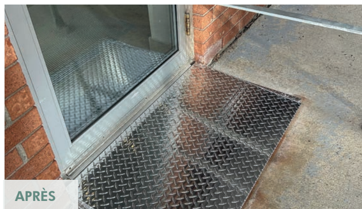
Remplacement de la rampe d'accès en acier à l'entrée du bâtiment au 225, rue du Progrès, à Gatineau
